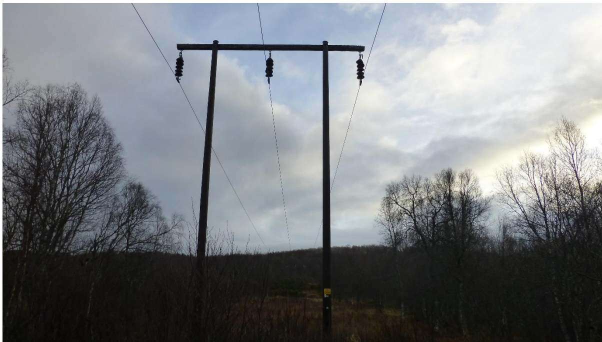
Figur 5-19. Portalpille av rundtømmer med tretravers og gamle porselensisolatorer.
