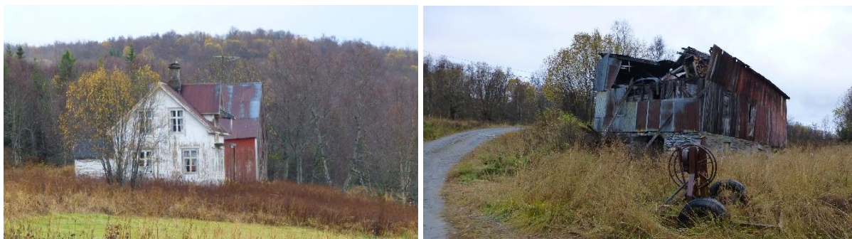
Figur 5-23. Øverst SEFRAK-registrert hytte i nordenden av Levangsvatnet. Nede til venstre bygningsmiljø på Skogvoll og løe til nedfalls på Sletta. Våningshuset på Sletta er revet.
